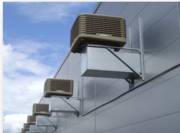
En toiture Soufflage vers le bas
