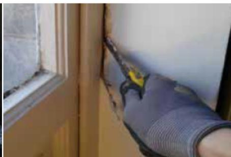
**2** Détourez les joints silicone des bords intérieurs
