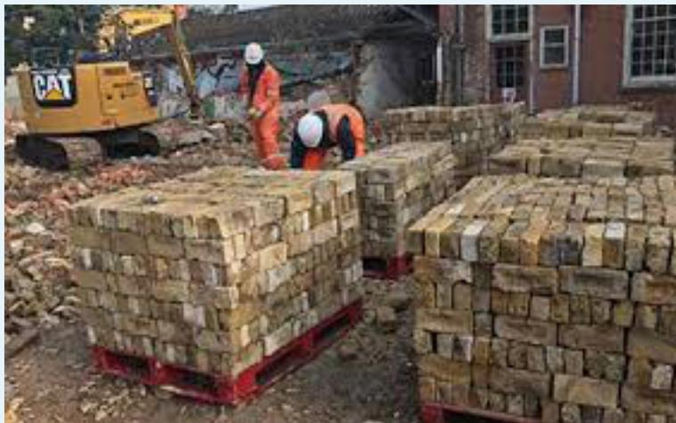
Photo n° 2 : Stockage des briques sur palette (<https://www.lrbm.com/>)
