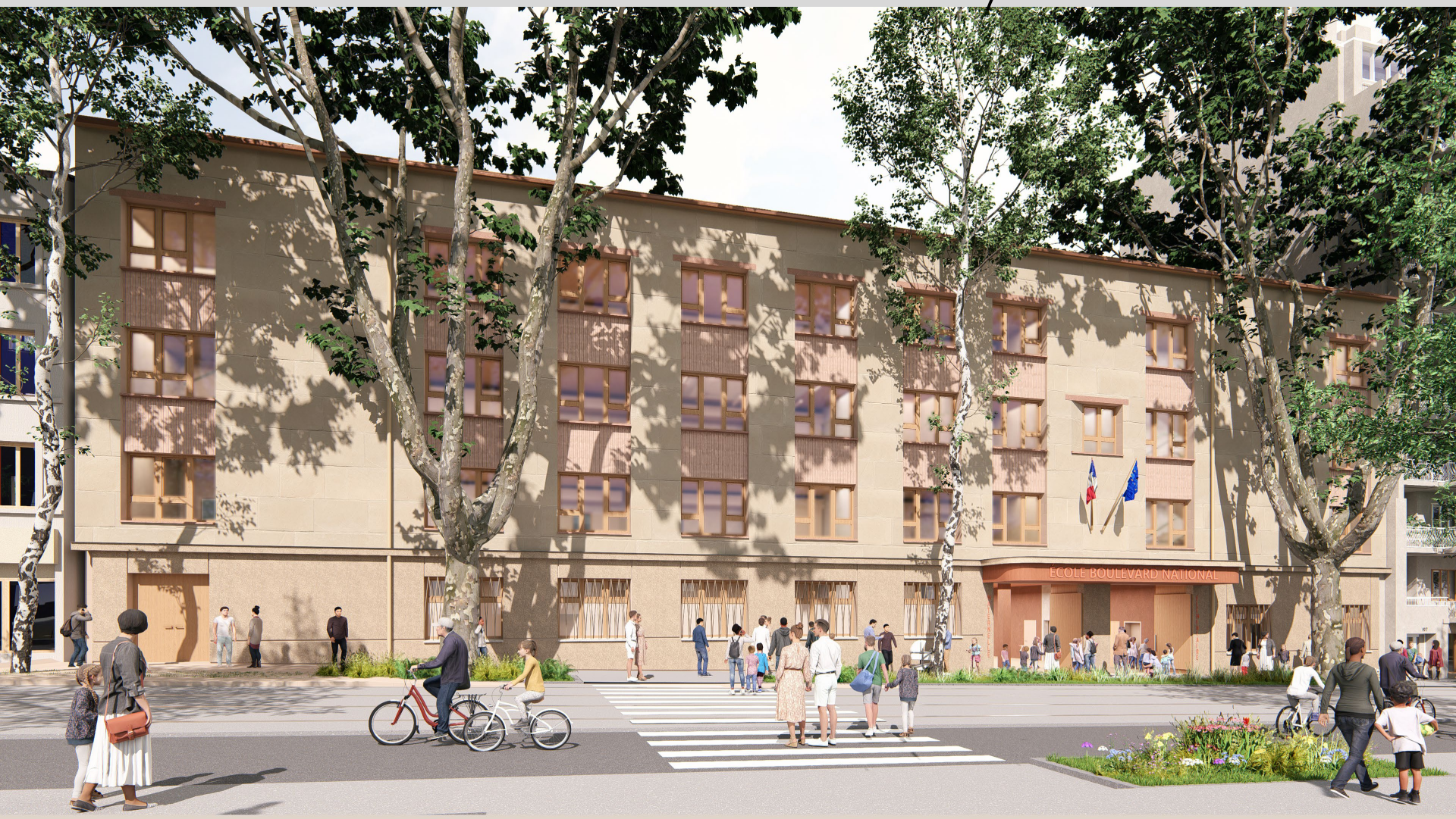
Vue côté boulevard / Phase PC
