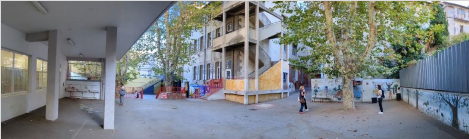
Côté cour / Espace minéral et platanes
