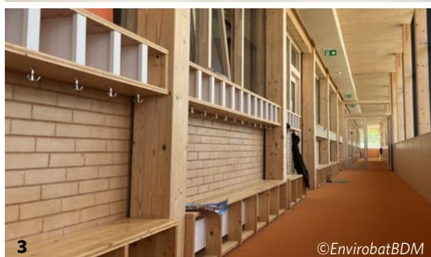
l'entreprise Cycle Terre (fermée à ce jour). L'ensemble respecte **un exigence Coupe-Feu 1h (EI60)**. L'entreprise et l'équipe de MOE se sont appuyées sur l'ATEx Cycle Terre (expiré aujourd'hui) et ont fait réaliser **un essai au feu** pour justifier le coupe-feu. L'essai a été réalisé au CERIB sur 2 prototypes : un prototype de h=4 m qui a obtenu un degré EI30, et un **prototype de h=3m qui a obtenu un degré EI240**.
