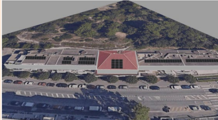
➤ Implantation de la centrale sur la toiture
