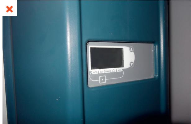
En période d'absence prolongée, l'alimentation électrique du CET sur air extrait est volontairement coupée. L'arrêt de la VMC peut générer une dégradation de la QAI et le développement de moisissures. ©AQC
