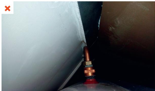
Absence de mitigeur thermostatique à la sortie du CET. Aucun autre mitigeur n'est présent entre la production et le point de puisage. Le risque de brûlure n'est pas contrôlé. ©AQC
