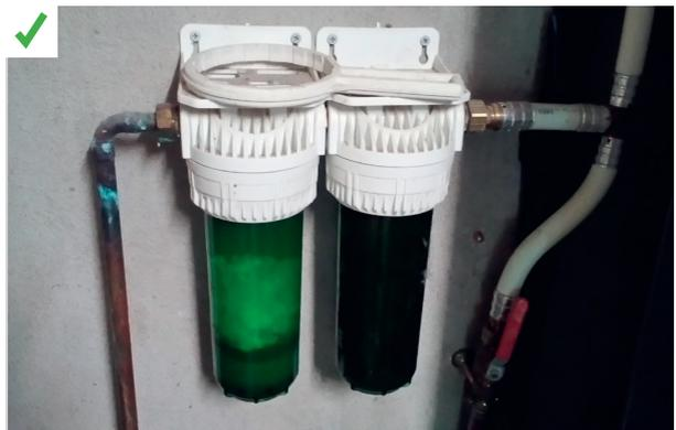
Mise en place d'un filtre à microparticules en amont du ballon d'eau chaude sanitaire. ©AQC
