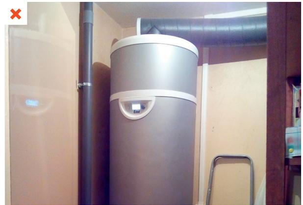
Le CET situé à proximité d'une chambre perturbe le sommeil des occupants. La cloison séparative et la traversée par la conduite aéraulique ne sont pas isolées acoustiquement. ©AQC
