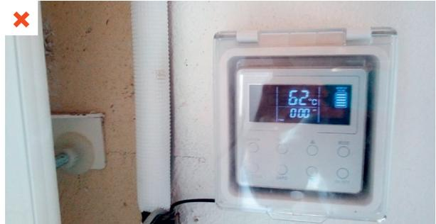
Lors du remplacement du chauffe-eau électrique par un chauffe-eau thermodynamique, la température de consigne a été programmée à l'identique, soit 62 °C. ©AQC
