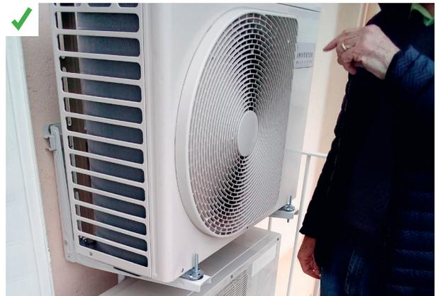
Le système à éléments séparés ou bibloc a été choisi pour éviter les nuisances sonores générées par le compresseur et le ventilateur. Ces deux éléments sont à l'extérieur. ©AQC
