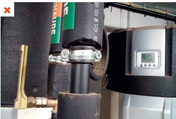
Le calorifuge de la canalisation d'eau chaude n'est pas continu et s'interrompt de part et d'autre du collier de maintien. ©AQC
