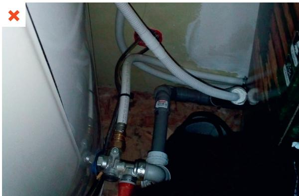
Dans ce local non chauffé, les canalisations d'eau chaude sanitaire ne sont pas isolées. La consommation d'eau chaude au point de puisage est plus importante pour obtenir la température souhaitée. ©AQC
