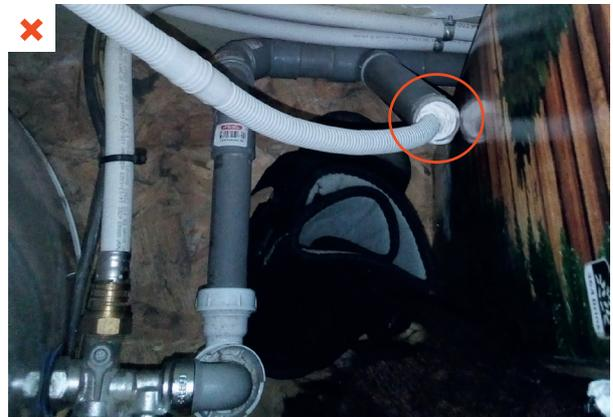
Le tuyau d'évacuation des condensats est relié au réseau d'évacuation, mais ne dispose pas de siphon. ©AQC
