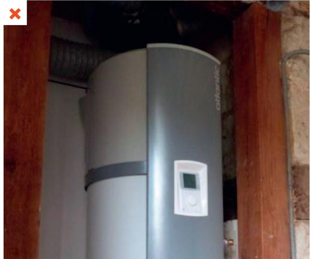
Le chauffe-eau est branché sur la VMC et est donc utilisé comme un CET sur air extrait, alors que le domaine d'emploi du produit ne le stipule pas. ©AQQC
