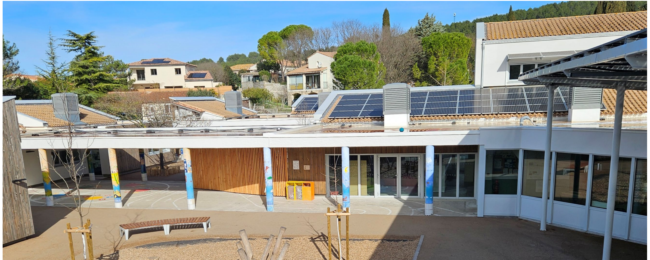
Vue d'ensemble extérieure toiture
