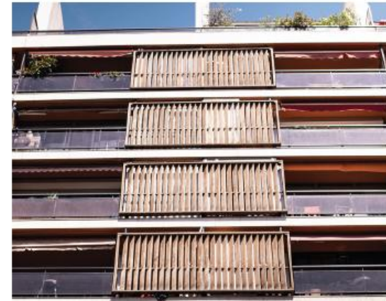
Dispositif mixte : store à projection + claire-voie en bois fixe sur une partie importante du balcon (Rue Peyssonnel/ Rue Melchior Guinot) © Alexandre Caors.
