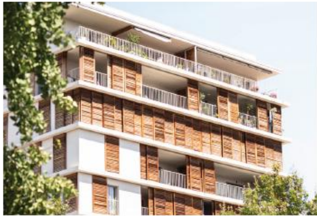
Des panneaux coulissants en bois persiennés permettant une protection de tout le linéaire de la loggia tout en assurant une porosité © Alexandre Caors.
