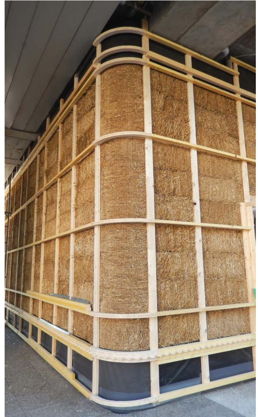
Jonctions des murs avec le plafond (dalle et poutre) et le plancher bas
