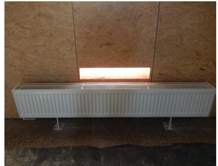
Radiateur positionné devant l'entrée d'air
