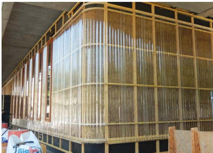
Murs préfabriqués posés sur site avec les ondulines laissant apparaître la paille
