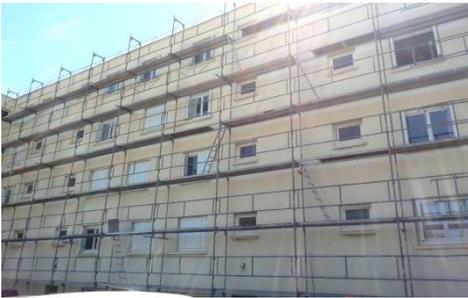
3. Isolation par l'extérieur en fibre de bois ©Sowatt
