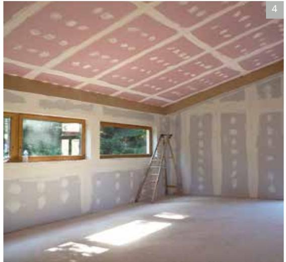
1. Panneaux préfabriqués assemblés vus de l'intérieur (R+1). 2. Pose de l'isolation en laine de bois entre les montants d'ossature (partie visible : film disposé sur une face des panneaux souples de la laine de bois ISONAT + FLEX pour optimiser le confort de pose). 3. Membrane frein vapeur avant la pose des 40 mm de laine de bois et des plaques de plâtre. 4. Après la pose des plaques de plâtre (© Yves BRÛLÉ)
