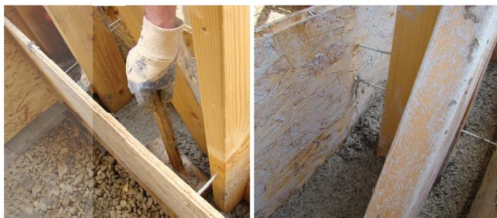
25 cm, alors la 1<sup>ère</sup> hauteur de banches pourra être enlevée par glissement latéral (le temps pendant lequel le mortier devra rester entre banches ne pourra être inférieur à 20 minutes).
