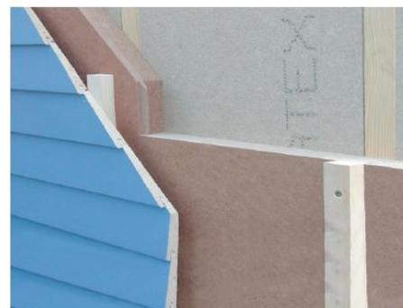
Il consiste en une ossature (en bois, acier, aluminium ou mixte bois/métal) fixée au mur, à laquelle est superposé un revêtement de parements manufacturés. Suivant le système choisi et les performances thermiques ciblées, l'isolation est amenée en une ou plusieurs couches croisées et d'épaisseurs variables, sous ossature et/ou entre montants d'ossature.
