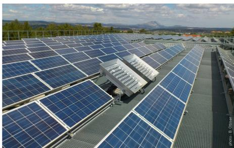
2 Sur-toiture couverte de panneaux solaires et capteurs de lumière à fibre optique
