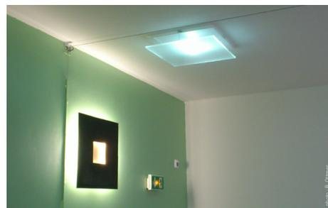
4 Diffuseur de lumière via fibre optique (haut) dans les circulations
