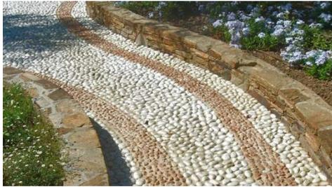
Les pierres sont posées sur du remblai ou, parfois, pour éviter qu'elles ne s'enfoncent, sur d'autres pierres posées horizontalement.
