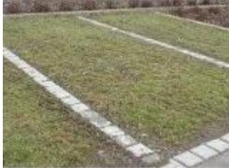
Il s'agit d'un mélange (perméable) de terre végétale et de gravier de diam. 2 - 64 mm, constitué d'une seule couche de mélange de 30 cm ou de deux couches respectivement de 30 cm de mélange et de 20 cm de support.
