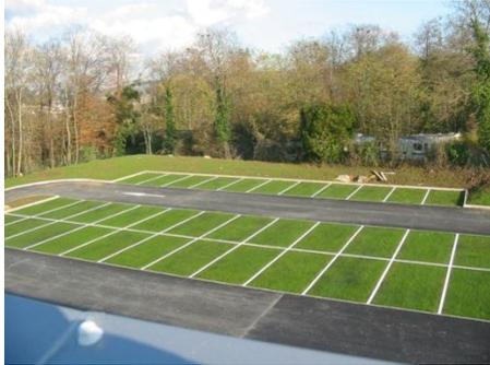
Béton bitumineux drainant, fabriqué à chaud ou à froid, de granulométrie 0/6 à 0/20, présentant un vide d'environ 35 %, recevant ensuite un coulis végétal ensemencé de graines de gazon.
