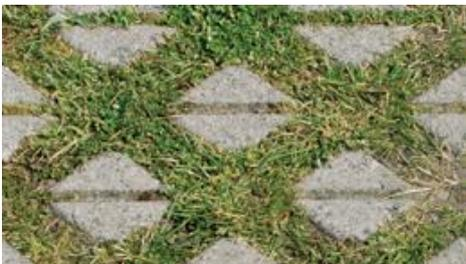
Après la pose, les dalles gazon en béton peuvent être remplies de terre arable. Le remplissage s'effectue jusqu'à 2 cm de la face supérieure de la dalle.
