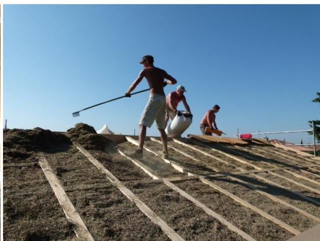
Exemple de mise en œuvre de paille de lavande en vrac en caisson, en paroi verticale et toiture, sur une maison individuelle à ossature bois.
