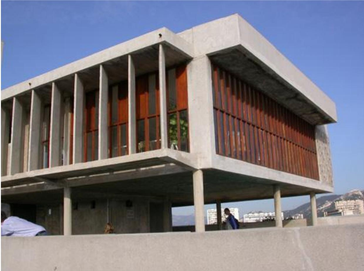
La protection solaire fixe (ici « structurale ») doit s'adapter aux orientations des façades: auvent au Sud, lames verticales à l'OUEST: Le Corbusier, Unité d'Habitation de Marseille (1953)
