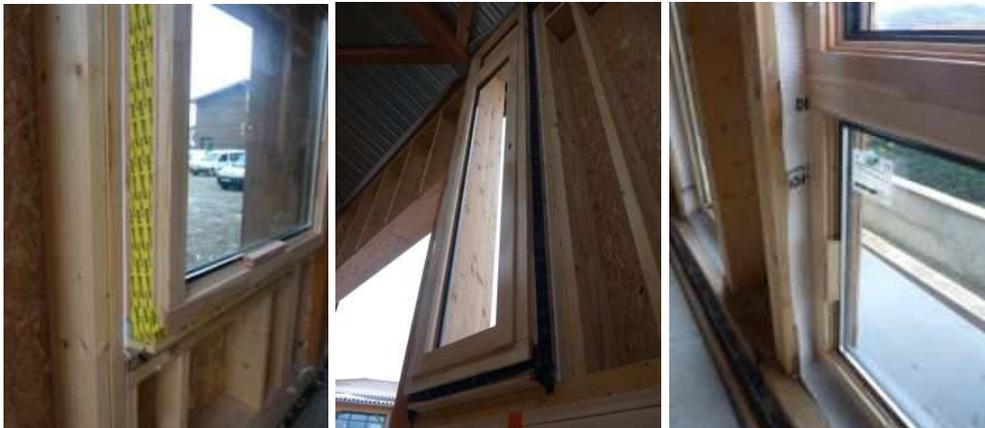
Profils posés en applique sur des précadres et continuité de l'étanchéité à l'air
