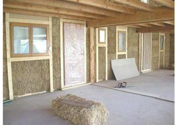
Grâce à cette isolation, la température intérieure est de 16°C minimum, même sous -10°C et elle est au maximum de 23°C, même en été lorsqu'il fait 35°C à l'extérieur.
