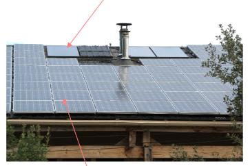
Les capteurs solaires permettent de produire jusqu'à 80% des besoins en eau chaude. L'installation a été raccordée au lave-linge qui est un gros consommateur d'énergie.
