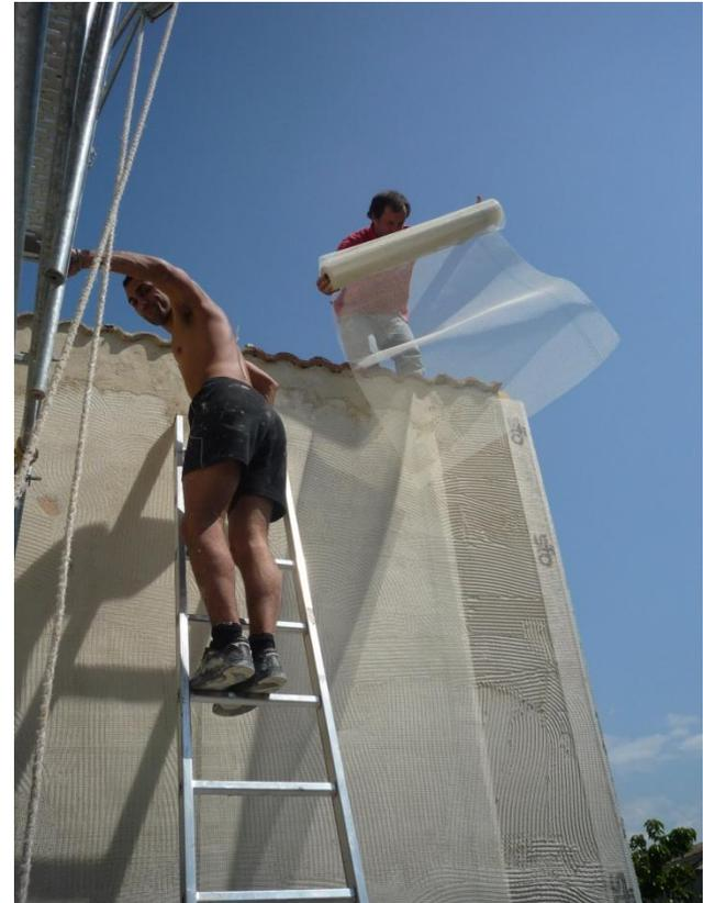
**Pose d'une primaire et de l'enduit de finition en une passe de 1.5 mm**
