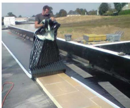
Mise en œuvre d'un revêtement d'étanchéité sur Knauf MulTTI (source : Knauf)
