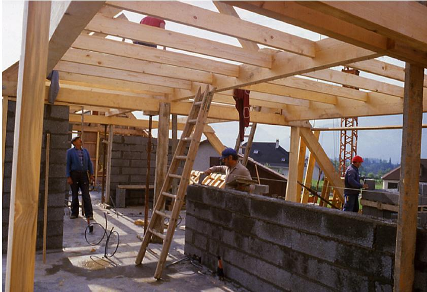
*Photo d'une structure bois avec maçons montant un refend : Structure mixte : la maçonnerie, intérieure, est montée après la charpente*
