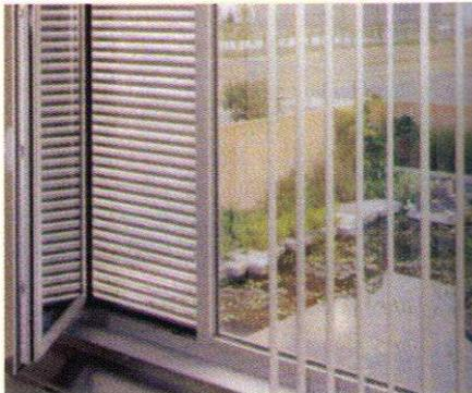
L'option « oscillo-battant » et les stores sont des solutions intéressantes pour permettre une ventilation nocturne du bâtiment sans forcément l'ouvrir à tous vents.
